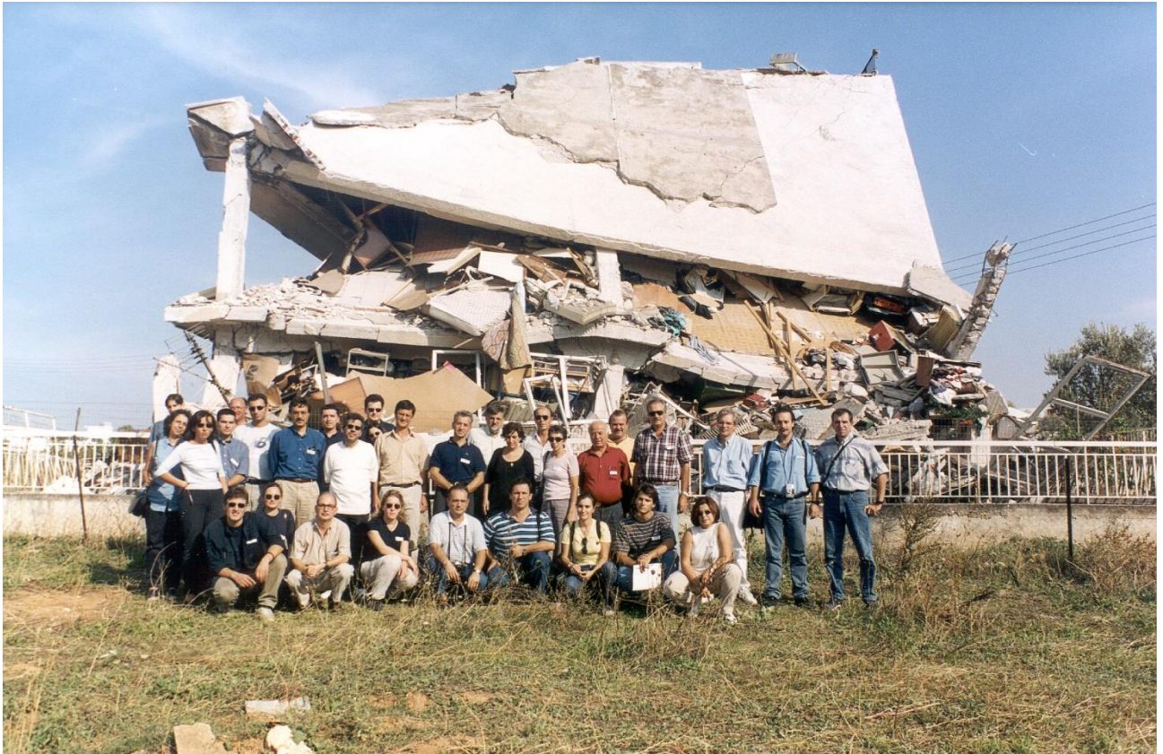
Μέλη του Εργαστηρίου Στατικής και Δυναμικής των Κατασκευών και άλλα μέλη ΔΕΠ με Μεταπτυχιακούς φοιτητές από αυτοψία σε κτίριο που κατέρρευσε από το Σεισμό της Αθήνας το 1999.
